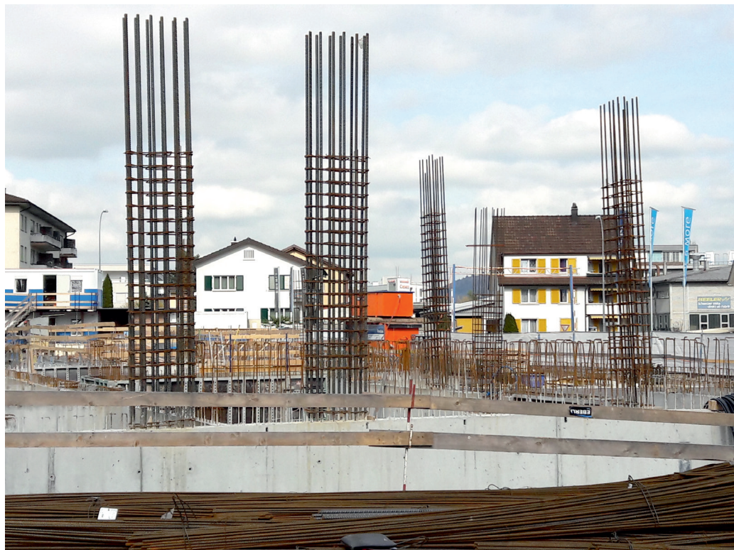
Erdbebenwand mit FISEISMA®-Bügelssystem in den Randbereichen.
