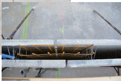
Stossverbindung bei Doppelwänden.
