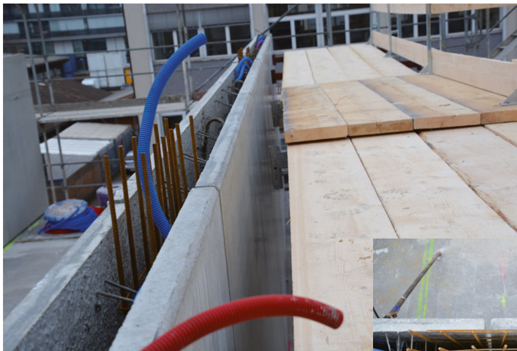
Stossverbindung bei Doppelwänden.
